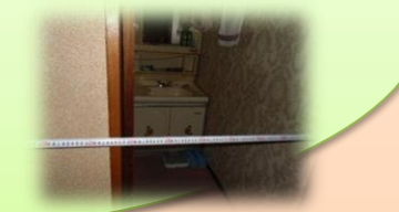
出入口が狭く、扉が内開きなので、入れそうもないね！また車いすでは使えない洗面台だなあ・・・。
